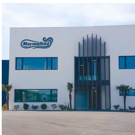
Cerramiento de edificio industrial, Cádiz
